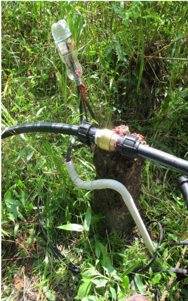
Auf dem Bild sieht man eine improvisierte Abzweigdose. In Indien heißt das: kostet wenig, muss funktionieren, sicher und einfach sein.
