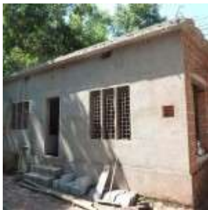
Das neue Haus
